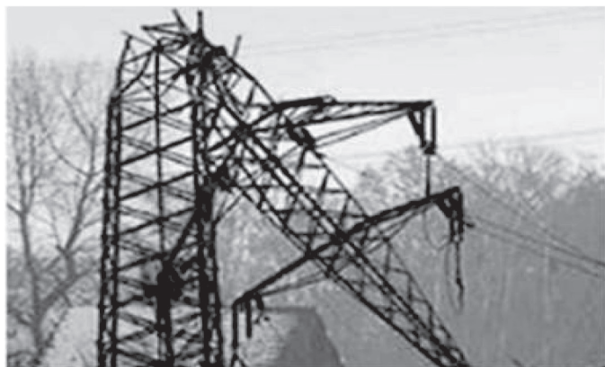
Рис. 1. Последствия гололёда для линий электропередач
